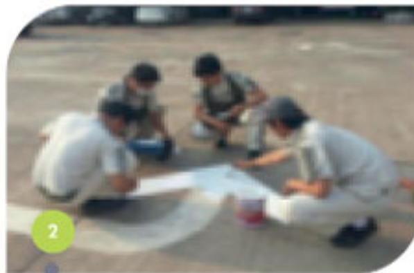
2 ซ่อมแซม Repair
