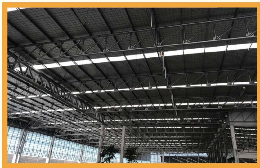
การติดตั้งหลังคา Sky lighting installation of Sky Lighting Roof
