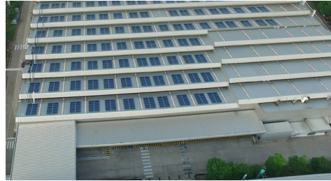
ปัจจุบัน โรงงานโตโยต้า(ลำโรง, บ้านโพธิ์และเกตเวย์) ได้ติดตั้ง แผงเซลล์แสงอาทิตย์ไปแล้วทั้งสิ้น 2.6 เมกะวัตต์(MW) สามารถผลิตไฟฟ้าได้ประมาณ 3,640 เมกะวัตต์-ชั่วโมง(MWh/year)
