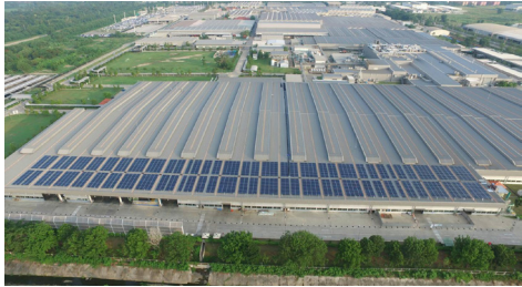
ปัจจุบัน โรงงานโตโยต้า(ลำโรง, บ้านโพธิ์และเกตเวย์) ได้ติดตั้ง แผงเซลล์แสงอาทิตย์ไปแล้วทั้งสิ้น 2.6 เมกะวัตต์(MW) สามารถผลิตไฟฟ้าได้ประมาณ 3,640 เมกะวัตต์-ชั่วโมง(MWh/year)
